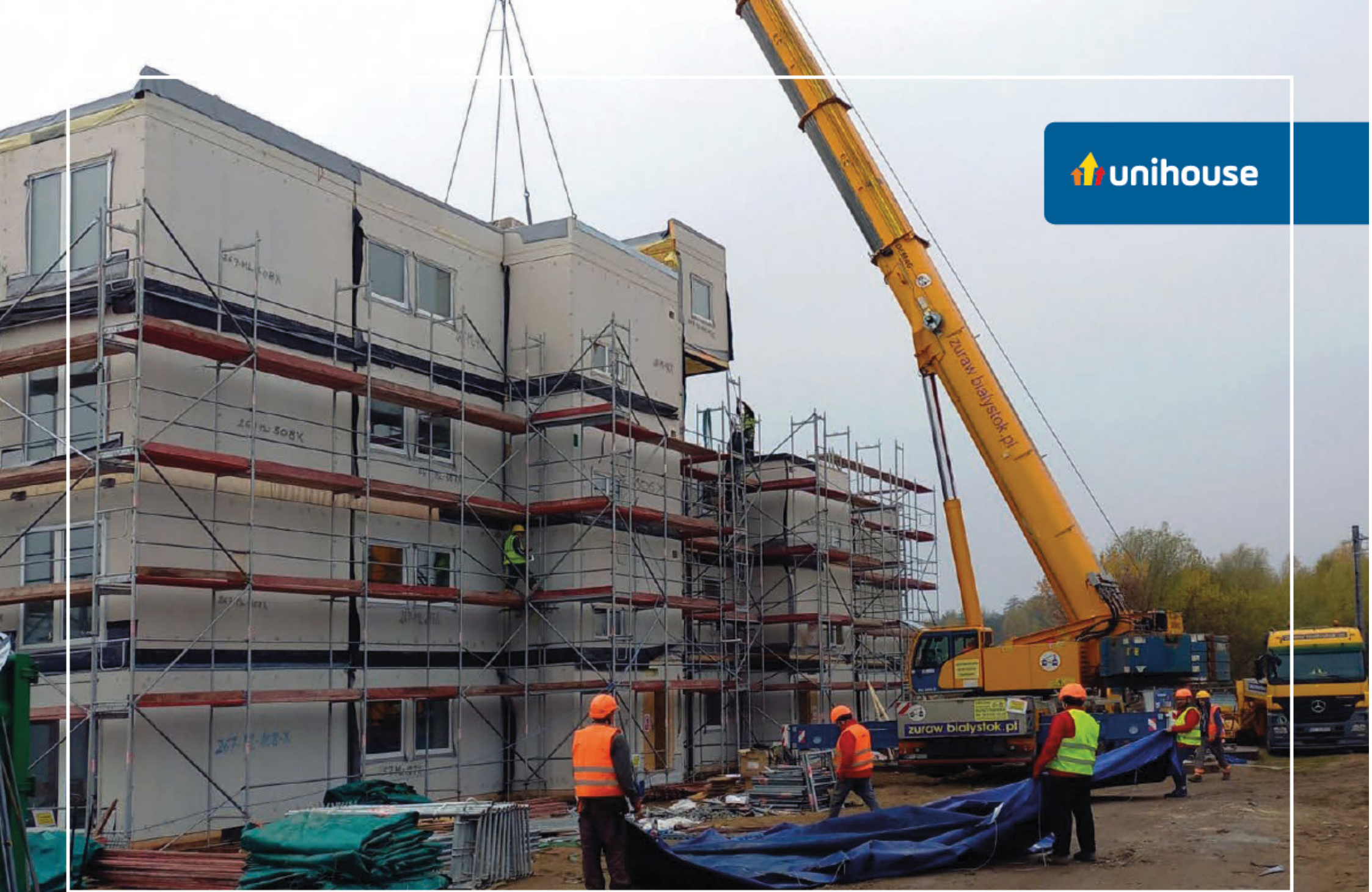
Збірка будівлі Building assembly
